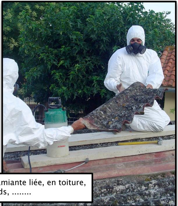
Dépose de matériaux d'amiante liée, en toiture, dalle de sol, faux plafonds, .....
